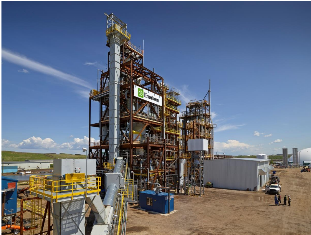
Usine Enerkem Alberta Biofuels à Edmonton, Alberta
